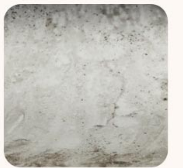
เครื่องปรับอากาศที่ไม่เคลือบสาร
